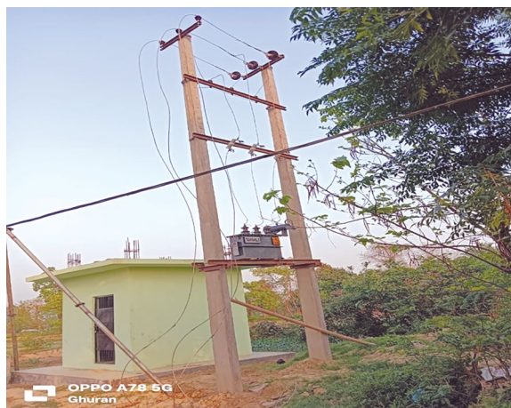
पम्प हाउस निर्माण, विद्युतिकरण तथा ट्रान्सफर्मर जडान कार्य, गैडहवा रूपन्देही महोत्तरी
